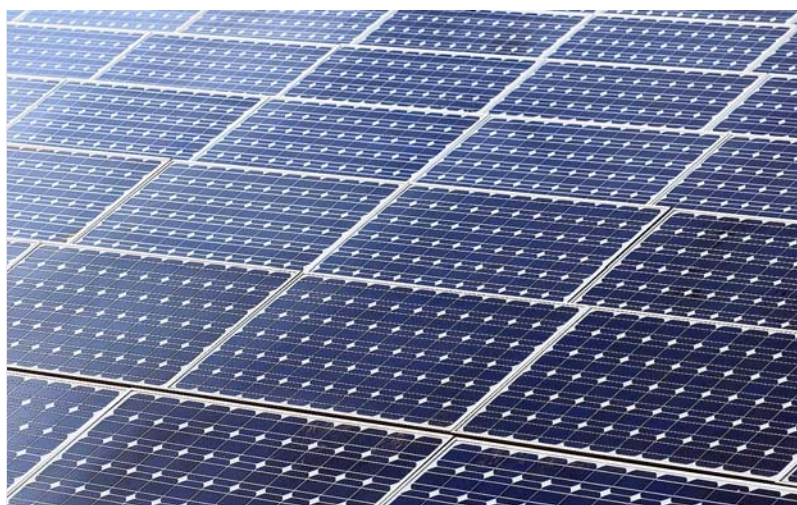
Auf einigen städtischen Dächern sollen Anlagen zur Gewinnung von Solarstrom installiert werden.
