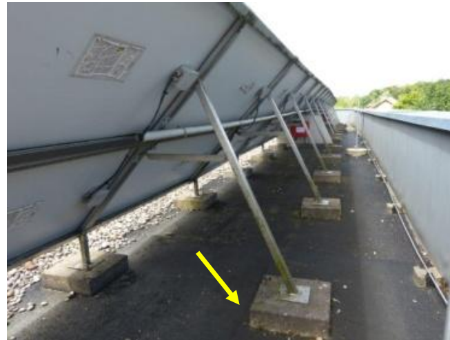
■ Unsachgemäß ausgeführter Schutz der Dachhaut. Belastung der Dachhaut durch schmale Kontaktflächen.
