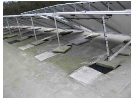
■ Unsachgemäß ausgeführter Schutz der Dachhaut. Belastung der Dachhaut durch schmale Kontaktflächen.
