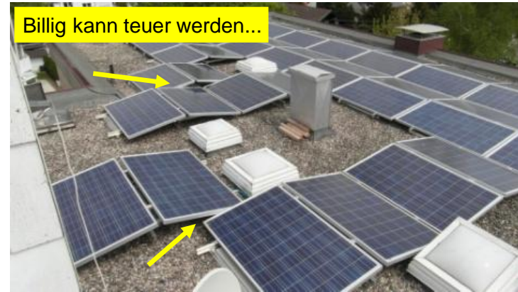
■ Zu geringe Abstände zu Schatten werfenden Elementen. Folge: niedrige Stromerträge.
