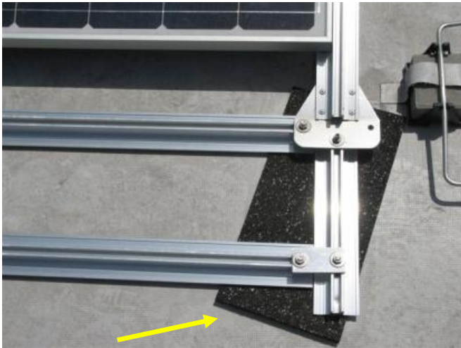
■ Unsachgemäß ausgeführter Schutz der Dachhaut. Belastung der Dachhaut durch schmale Kontaktflächen.
