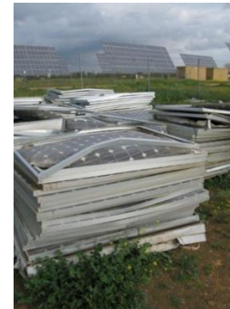
■ Durch Sturm beschädigte Module
