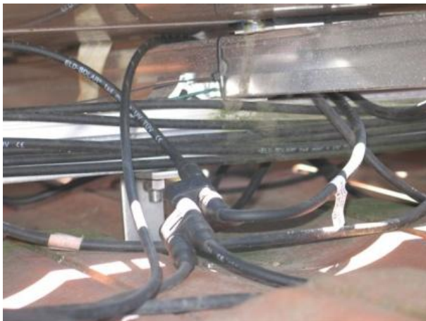
■ Unsaubere Verlegung der Verkabelung.
