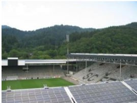
Stadion SC Freiburg, >> 100 kW
