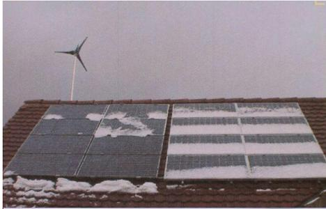
Die Module mit Alurahmen weisen im Laufe der Zeit deutliche Schmutzablagerungen und im Winter längere Schneebedeckung auf.
