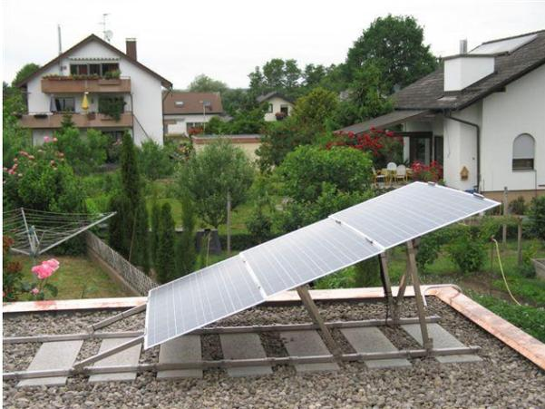
Optimale großflächige dachschonende und variable Verteilung der Druckbelastungen z.B. bei Schneelast auch zwischen den Reihen...
